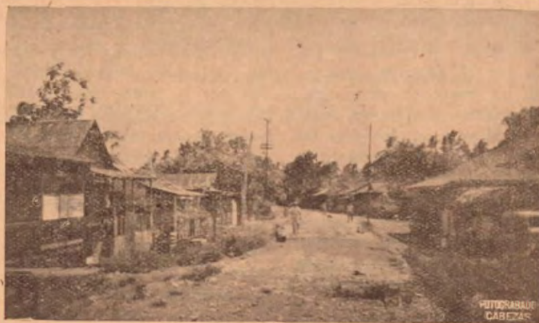
Una calle del caserío de Cieneguita en Limón, unido al puerto por un pequeño puente de madera en mal estado. Ahora se está construyendo uno nuevo. Por esta calle pasó antaño la línea del Ferrocarril.
